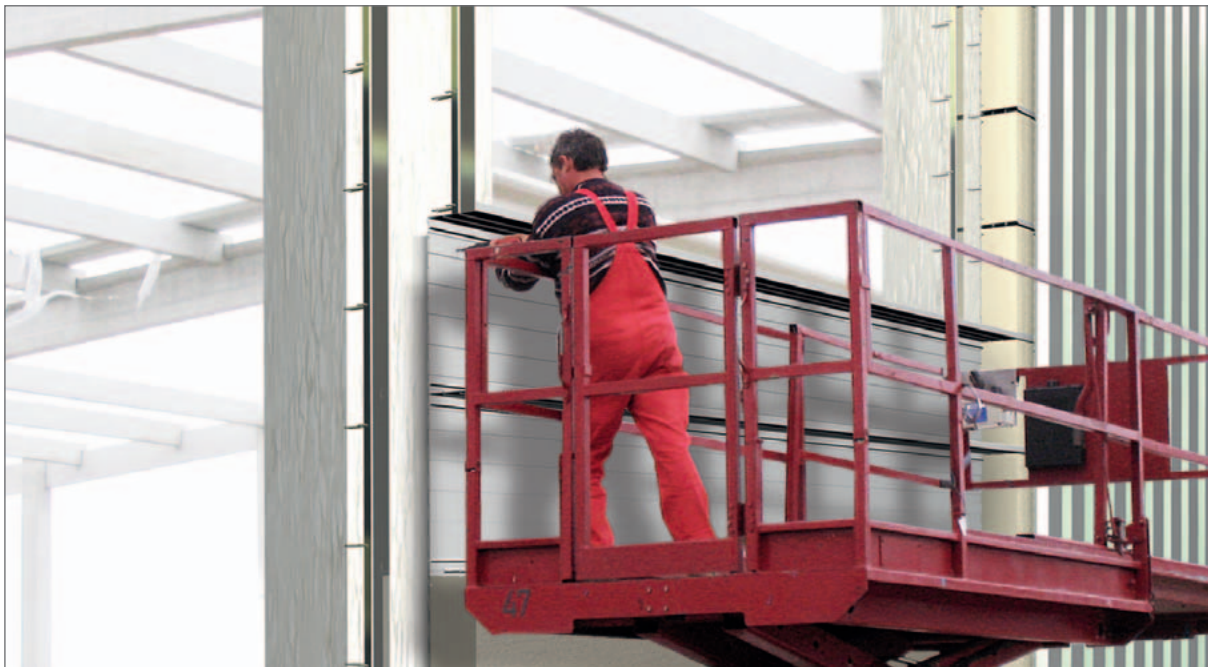
Montage einer mehrlagigen isolierten Trapezblech-Wand.
