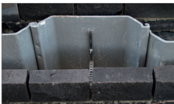
Anschluss von Verblendmauerwerk an Spundwand.
