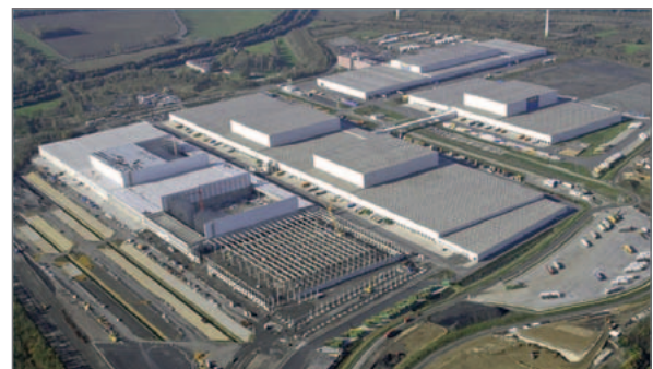
Befestigung auf dem Dach.
