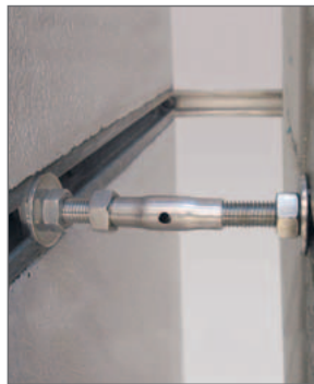
Spannverbindungen JSV zur dreidimensionalen Ausrichtung.
