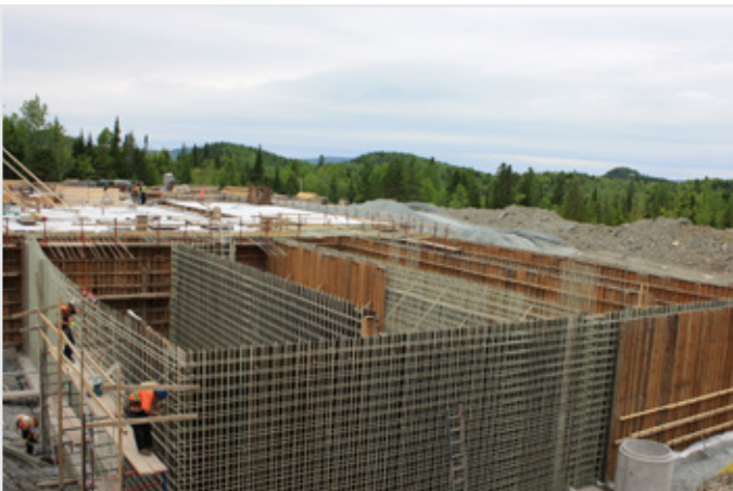
Tanks für Kläranlage, Wand- und Bodenplattenbewehrung
