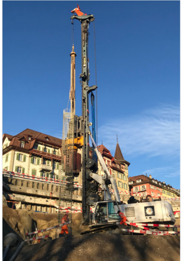
Bohrpfähle der Baugrube Wildpark Bahnhof Bern, Schweiz
