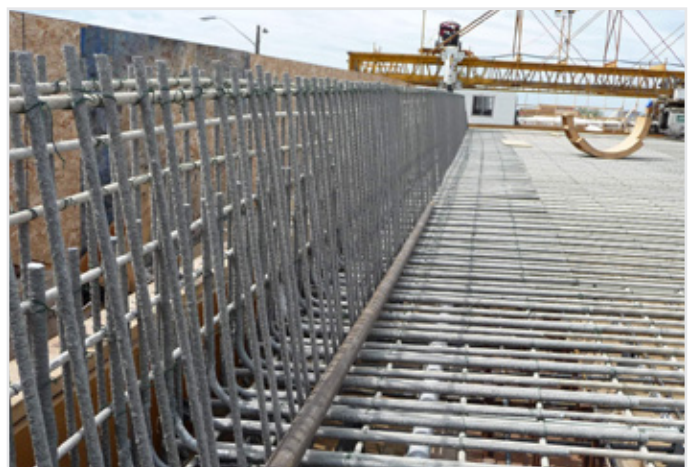
Einbau von FIBERNOX® V-ROD in Brückendeck und Betonleitplanken
