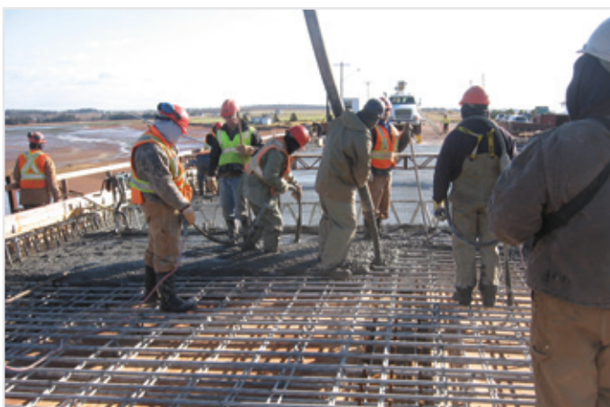
Victoria Brücke, Kanada
