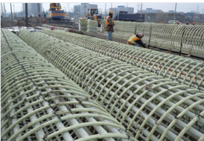
Bewehrungskörbe aus FIBERNOX® V-ROD mit geraden Stäben und Wendelbewehrung
