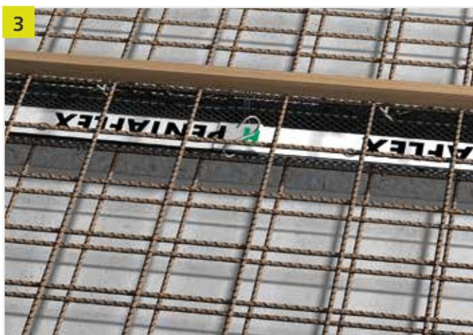
Verlegen der oberen Bewehrung und Abschalung der oberen Betondeckung. ABS Element an der oberen Bewehrung mittels Bindendraht befestigen. Wahlweise das Element mit der Bewehrung verschweißen.
