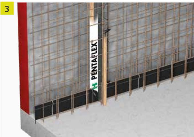
Innere Bewehrung einstellen und mit dem ABS Element verbinden (Bindedraht, schweißen). Trapezleiste befestigen und Schalung schließen. WU-taugliche Spannstellen verwenden.
